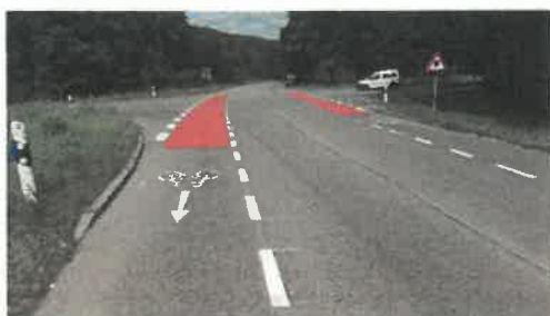
Abb.: Mehrzweckstreifen mit Kernfahrbahn in Deutschland (© Gemeinde Königsbrunn)
