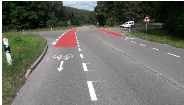
Abb.: Mehrzweckstreifen mit Kernfahrbahn in Deutschland (© Gemeinde Königsbronn)
